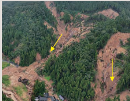
石川県輪島市町で発生した地すべり
