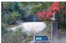
オランダ堰堤(大津市)
