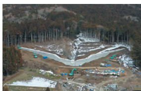
伊吹山土砂災害対策箇所(米原市)
