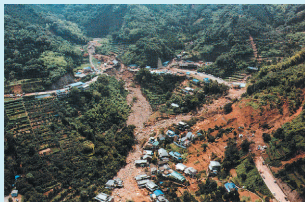
土砂災害防止月間の契機となった長崎豪雨災害
