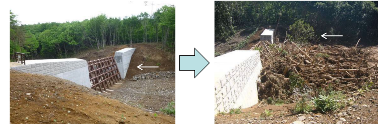
小水無沢第1砂防堰堤
