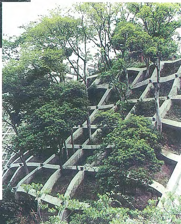
■斜面の樹木を残し、緑との共生をはかる。 そまに （柚谷山腹工）
