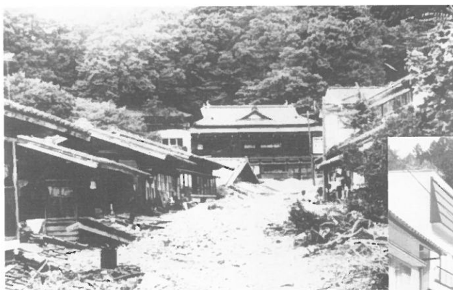
被災状況 1階は全て土砂で埋っている
