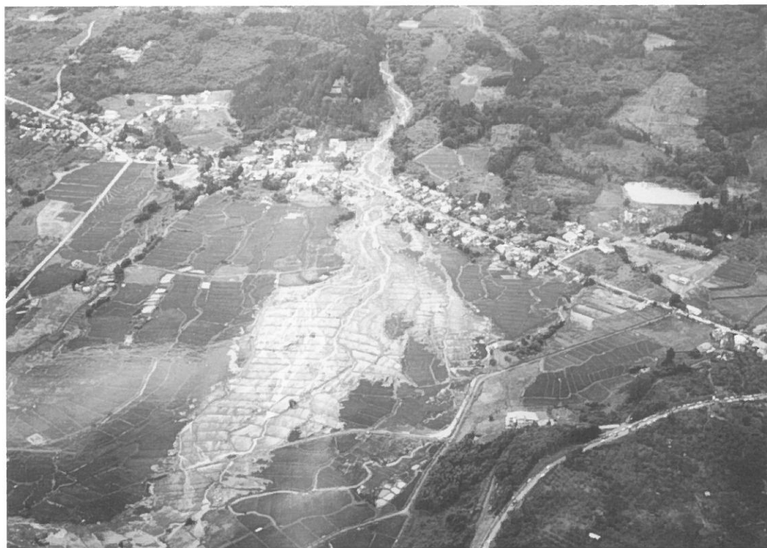
土石流被災状況 岩木川水系蔵助沢
