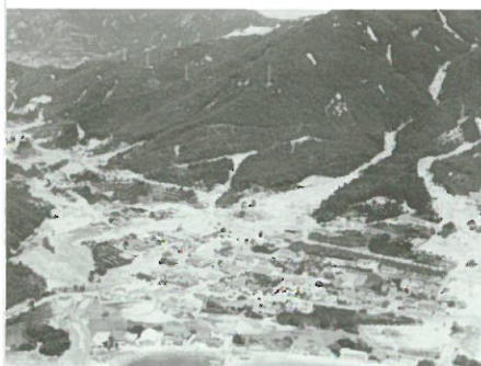
昭和51年被災状況
