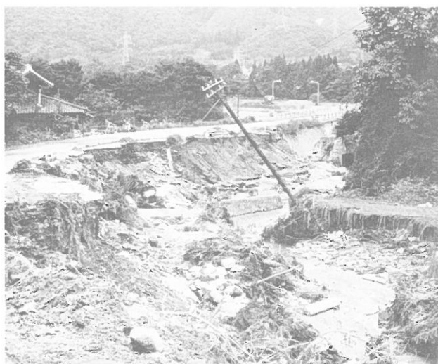
黒川村胎内川被災状況
