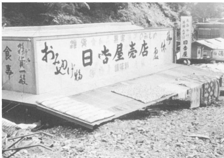
土砂で埋もれた梅ヶ島温泉の被災状況
