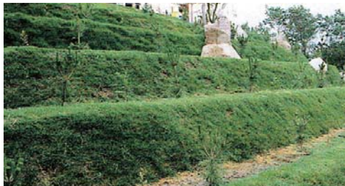
山腹工は滋賀県の田上山で実際に行われている工法を再現し、「砂防による緑の復元」をアピールした
