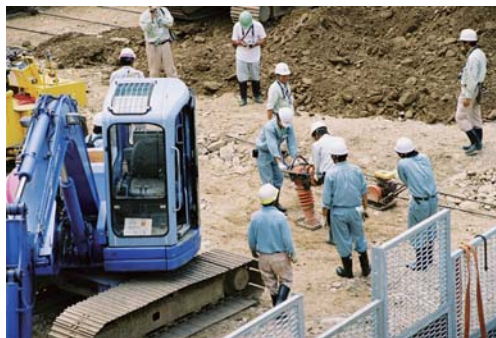
事務所職員の指導でコンクリート締固め作業を行う参加者
