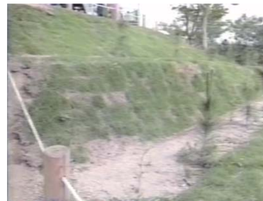
滋賀県田上山での工法を再現した山腹工
