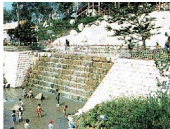
「鎧堰堤」は明治初期にオランダ人技師・デ・レイケが築いた石積砂防堰堤を再現した
