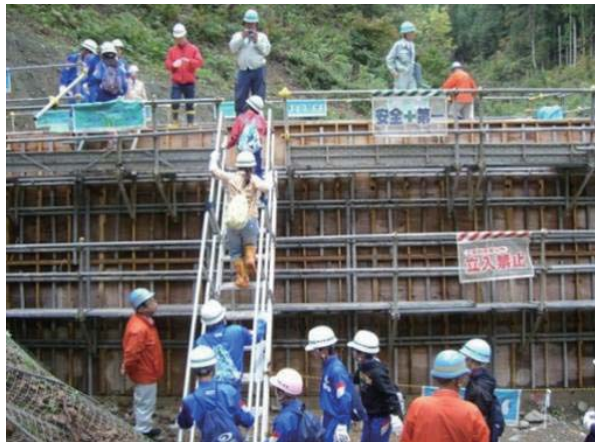
砂防ボランティアによる現地見学会（福島砂防ボランティア協会）
