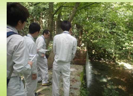
砂防施設点検
