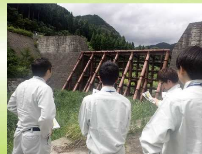
砂防工事現場見学
