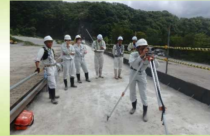
砂防工事現場見学
