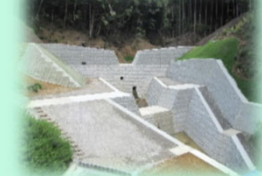
既設の砂防堰堤
