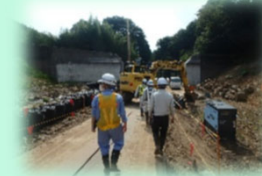
砂防堰堤の工事現場
