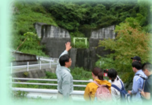
既設の砂防堰堤
