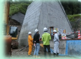
砂防堰堤の工事現場
