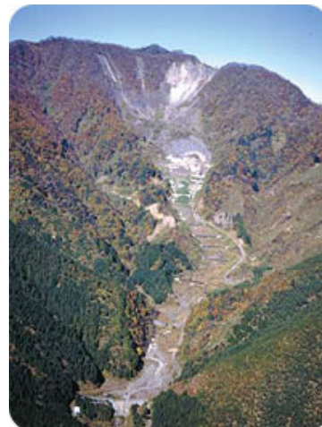
根尾白谷大崩壊地
