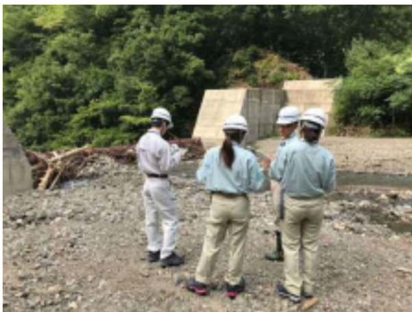
◆砂防堰堤視察
