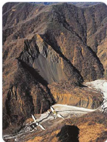
徳山白谷大崩壊地
