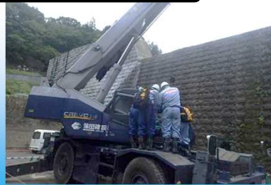
中尾第4号砂防堰堤
