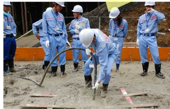
実務体験（コンクリート締固め）
