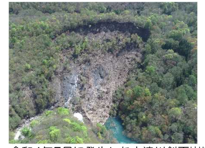
令和4年5月に発生した中津川斜面崩壊に対する初動対応（栄村）
