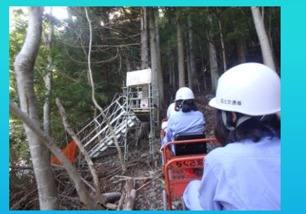
工事現場見学（夜子沢砂防堰堤）
