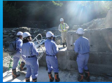
工事現場見学（夜子沢砂防堰堤）
