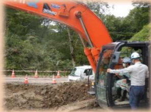
現場体験：MC付きBH操作体験 （ICT土工実施現場）
