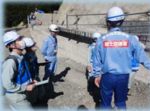
現場体験：松沢砂防堰堤工事用道路
