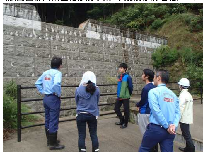
現場視察(大町地区) ー小規模溪流対応型砂防堰堤ー
