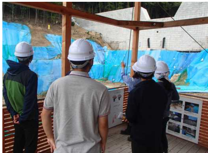
現場視察(八木地区) ーH26. 8. 20広島土砂災害復旧現場ー
