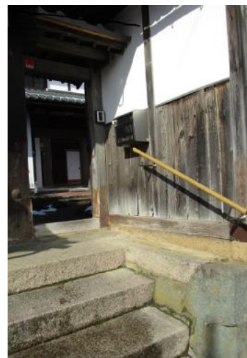
☆階段に手摺りを取り付けました。H30・12
