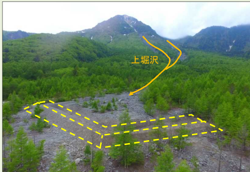
土石流減勢工 完成状況（無人航空機にて撮影）
