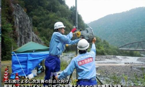
土石流による二次災害の防止に向け、監視カメラとワイヤーセンサーを設置するための現地調査を実施
