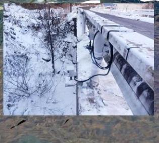
土石流による二次災害の防止に向け、監視カメラとワイヤーセンサーを設置するための現地調査を実施
