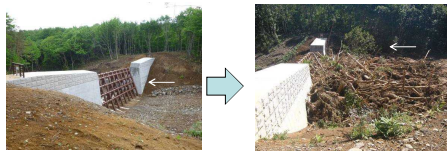
小水無沢第1砂防堰堤
