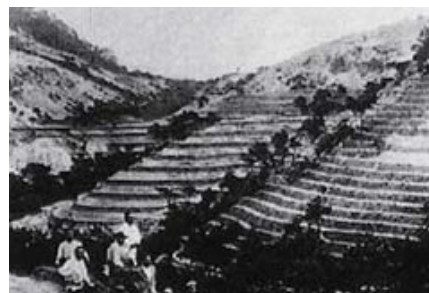
Mitatabi-yama, Núi Rokko khi bắt đầu trồng cây Sườn đồi được canh tác thành các bậc đều nhau và cây con đã được trồng
