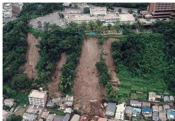
Sạt lở đất tại vùng bình cao Shirasu (một khu đất rộng được hình thành do tro núi lửa bồi đắp) (Thiên tai mưa lớn tại Kagoshima năm 1986 / Thị trấn Hirano, TP. Kagoshima, Tỉnh Kagoshima)
