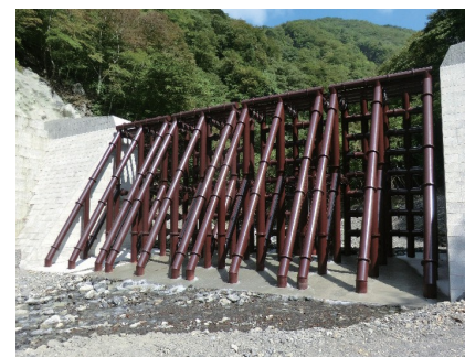
Đập Sabo dạng hở (Đập Sabo Ozawa số 3, TP. Hokuto, Tỉnh Yamanashi)
