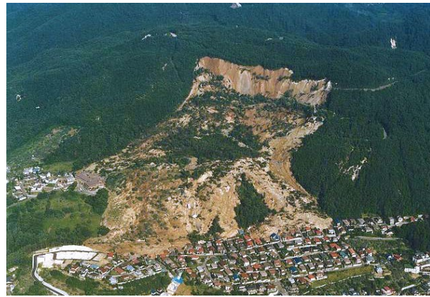
Trượt lở đất (Trượt lở đất Jitsukeyama năm 1995, TP. Nagano, Tỉnh Nagano)
