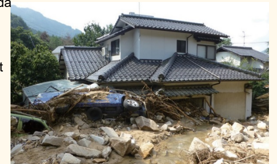
Dòng chảy bùn đá do trận mưa lớn ở miền bắc Kyushu khiến tầng một của ngôi nhà gần như bị lấp đầy bởi đất và cát, nhưng tầng hai lại không bị vỡ.
