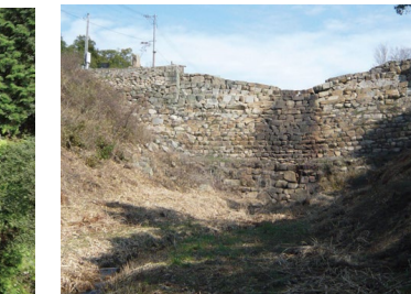
Đập Sabo số 6 DouDougawa (Tp. Fukuyama, tỉnh Hiroshima hoàn thành năm 1835)
