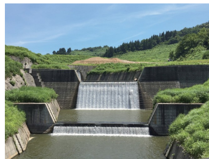
Đập Sabo dạng kín (Đập Sabo Higashitakesawa số 1, TP. Nagaoka, Tỉnh Niigata)
