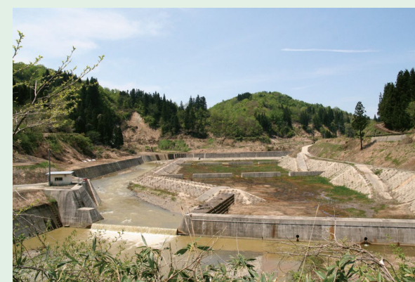
Hình ảnh bở bồi lắng tại khu vực Ryukou tp. Uonuma-shi, tỉnh Niigata
