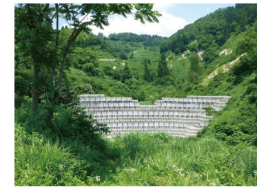
Đập Sabo Azumagawa (Tp. Nagaoka, tỉnh Niigata hoàn thành năm 2006)
