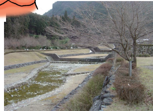
Công trình ổn định lòng dẫn (Sử dụng làm công viên Đan đan, Tt. Kaizu, tỉnh Gifu)
