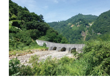
Đập Sabo ống Urakawa (Làng Otari, tỉnh Nagano hoàn thành năm 1998)
