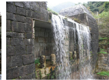
Đập Sabo số 1 Washizudani (Làng Neo, tỉnh Gifu hoàn thành năm 1996)
