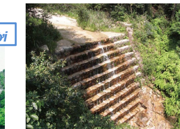
Đập Sabo Yorui (Tp. Otsu, tỉnh Shiga hoàn thành năm 1889)
