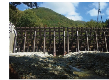
Đập Sabo Bitouzawa (Tp. Nikkou, tỉnh Tochigi hoàn thành năm 2012)
