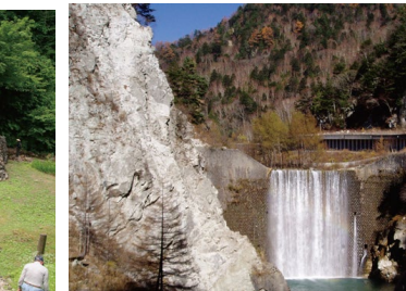
Đập Sabo Kamagafuchi Akatan (Tp. Matsumoto, tỉnh Nagano, hoàn thành năm 1943)
