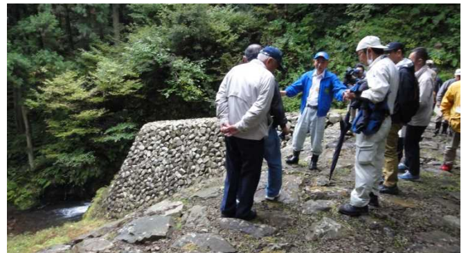
奥の東（7号）堰堤の見学。雨も止んだ
