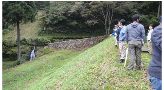
最後に8号堰堤（土堰堤）を見学
