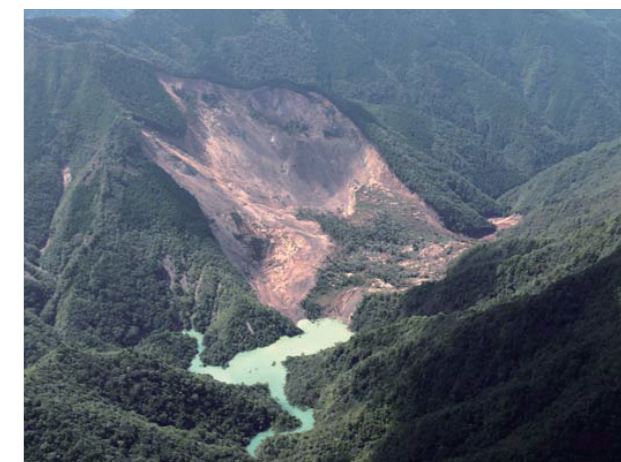
집중호우에 따라 붕괴된 토사에 의한 하도폐색(천연담) (2011년 태풍 12호, 나라현(奈良県) 토츠강마을(十津川村))
