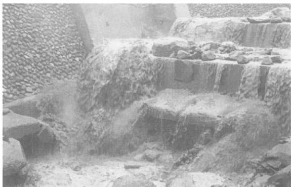
第3号砂防ダム床固工前面洗掘状況
