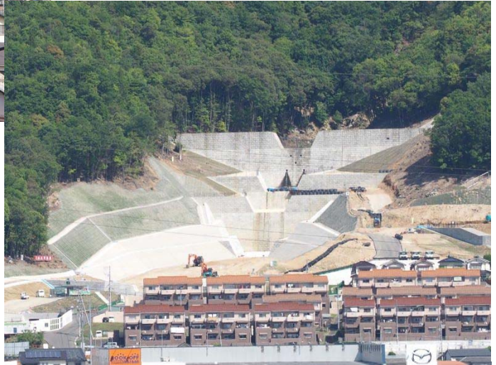
写真-2 八木3丁目 小原山砂防堰堤
