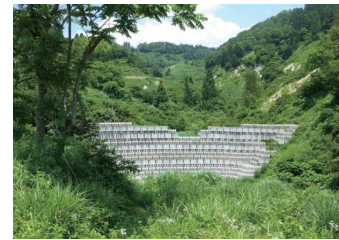
东川防砂堤 (新潟县长冈市, 2006年完工) 用大石块堆砌的非透过的防沙堤。
