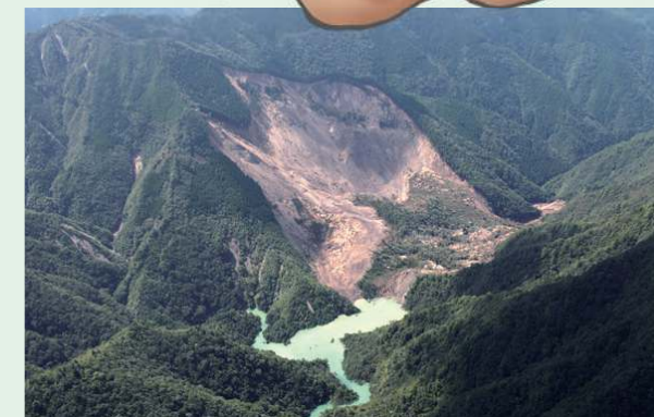
因大雨发生的深层崩溃(2011年·台风12号，奈良县十津川村) 塌落的砂土堵塞了河道而发生。
