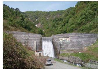
泷泽川第2防砂大坝 (新潟县汤泽町, 1988年完工) 可以水力发电的非透过的防沙堤。
