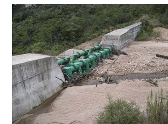
阻挡泥石流的透过型防砂堤(山口县防府市,八幡川溪流第1号防砂堤(钢制防砂堤B型))
