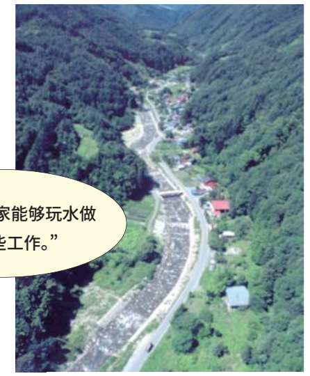
溪流保全工(长野县松本市野麦卡路路工) 河岸被修建成公园。
