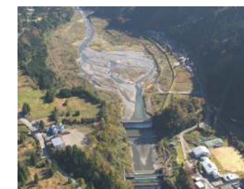
调节泥沙流动的非透过型防砂堤(富山县富山市,本宫)
