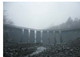
稻荷川第10上游防砂堤 (栃木县日光市, 2008年完工) 堤坝上有很多“开衩”的透过的防 沙堤。
