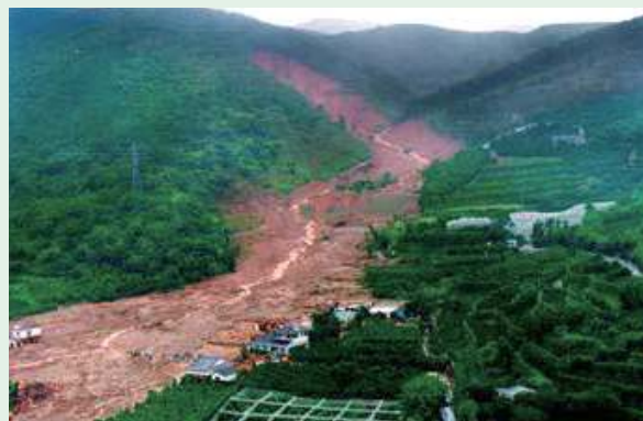
因深层崩溃发生的土砂灾害(1997年，鹿儿岛县出水市) 这次土砂灾害灾害21名居民丧生。
