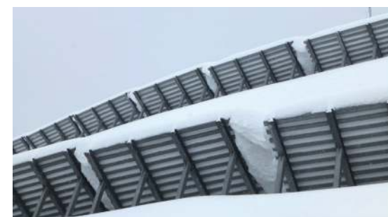
预防栏 在山坡斜面上设置多层防护栏，阻挡雪崩滑落。
