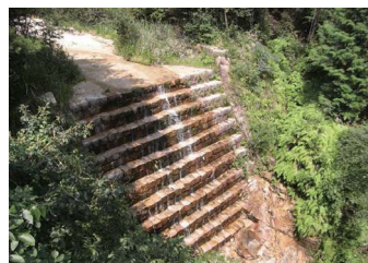
铠堤坝(滋贺县大津市, 1889年 完工) 是日本现存堤坝中第二古老的。在 明治时代由荷兰人技师指导下完 成。整体是由11级阶梯状的石头 堆积而成。
