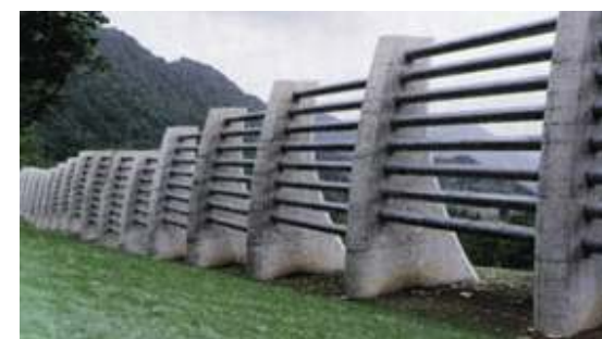
防护栏 在山脚下修建防护栏，和防护墙。即便发生雪崩，也能防止直接冲击民房。
