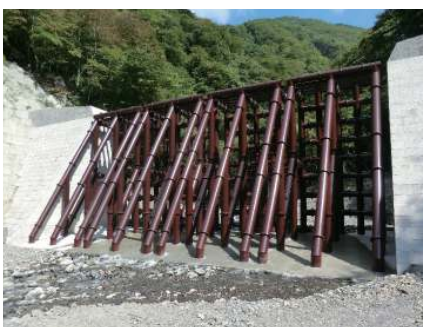
透过型堤坝(山梨县北杜市、大泽第3防砂堤) 堤坝留有空隙,从下游方向能看到上游。 透过型堤坝有很多种类,照片中的被称为钢质防砂堤(格子型)。
