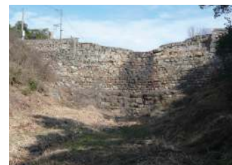
堂川6号砂留 (广岛县福山市, 1835年完工) 注册的有形文化财产(2006年注册) 建于江户时代后期, 是由被称为“大 砂留”的石头堆砌。周围还有同类 型砂留40余处留存至今。
