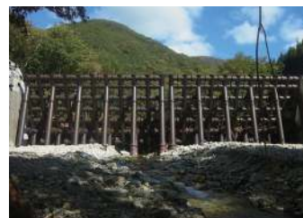
尾头泽防砂堤 (栃木县日光市2012年完工) 被称为钢制防沙堤J型的透过的防 沙堤。 (摄影:防沙钢构造物研究会)
