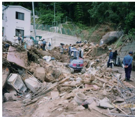
在斜坡上的住宅区的受害状况 (1999年·梅雨前的暴雨，广岛县吴市)
