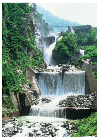
白岩防砂堤 (富山县立山町, 1939年完工) 重要文化财产(2009年认定) 作为立山火山喷发口防砂事业的关 键, 也是日本近代防砂象征的堤坝。 该防沙堤和周边设施是最早被认定 为国家重要文化财产的。高63m(加 上七个副坝总高108m)为日本最 高。
