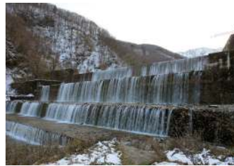
源太郎防砂大坝 (长野县白马村, 1963年修缮完工) 设置在时常泛滥的姬川上游松川 231m的非透过的防沙堤。成为稳 固姬川流域防砂工作的关键。
