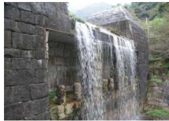
鹭津谷第1防砂堤 (岐阜县根尾村, 1996年完工) 为了与周边景致相协调, 在非透过的 堤坝表面贴了天然石块(花岗岩)。还 在从背面也能观测水流落下上下了功 夫。
