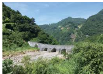
浦川超级暗渠防砂堤 (长野县小谷村, 1998年完工) 堤坝中有四个暗渠(隧道状的孔), 堤坝上还可作为一般道路通行使 用。
