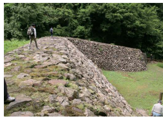
Akatan防砂堤群(福井县南越前町) 注册的有形文化财产(2014年注册) 明治30年代(1897-1906年)在 赤谷川修建的由7基石堆堤坝以及 2基土堆堤坝组成。
