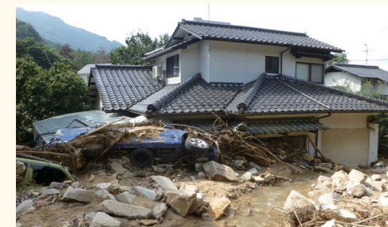
九州北部暴雨中被泥石流侵蚀的房子 1楼基本被泥沙覆盖，2楼并没有被破坏。
