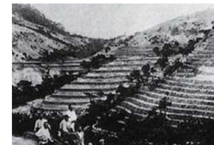
开始建造山腹工的六甲山地区再度山 沿着等高线将斜坡做成阶梯状, 然后再 种植树苗。
