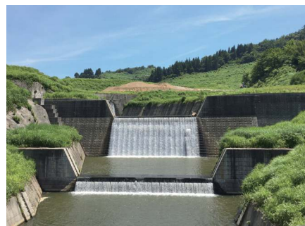
非透过型防砂堤(新泻县长冈市、东竹泽第1号防砂堤) 堤坝像墙壁般,从下游方向看不到上游。
