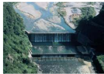
本宫防砂堤(富山县富山市立山町, 1937年完工) 注册的有形文化财产(1999年注册) 高22m、长107m拥有日本第一的 蓄沙量, 保卫着常愿寺河流域。
