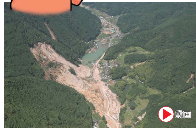
平成29年7月九州北部暴雨引发的河道堵塞(2017年、大分县日田市) 砂石阻塞河流形成天然水坝
