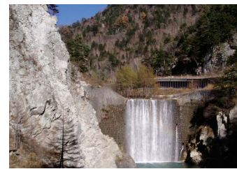
釜渊防砂堤(长野县松本市, 1943 年完工) 注册的有形文化财产(2002年注册) 在山地入口的梓川溪谷建造的防沙 堤。
