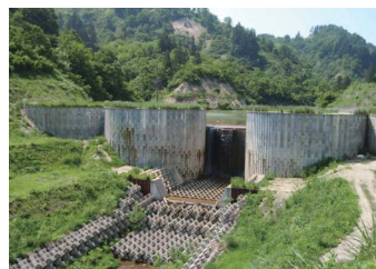
神泽川第1号防砂堤 (新潟县长冈市, 2006年完工) 是一种叫塞尔坝的防沙堤。在钢制 的大圆桶里填装的是混合了工程现 场的沙土和水泥。
