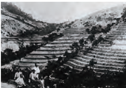
Monte Futatabi, montanhas Rokko, no início da obra na encosta
