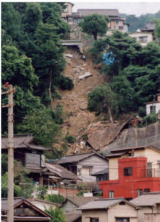
Casas destruídas pelo desabamento
