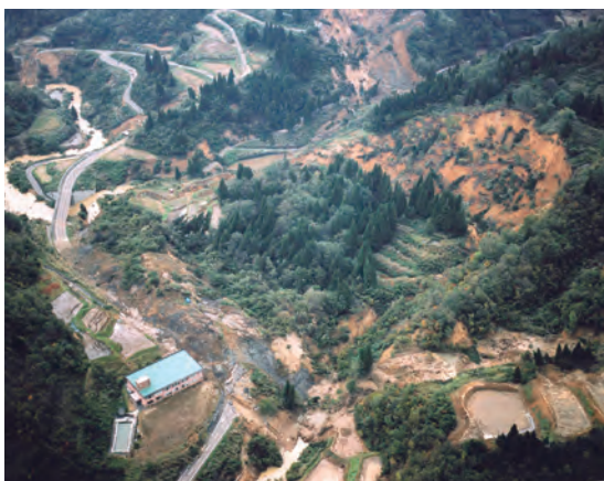
Deslizamento de terra causado pelo terremoto de Chuetsu, Niigata
