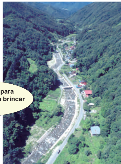
Obra de proteção contra torrente de montanha
