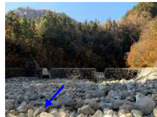
黒薙川第4号砂防堰堤
