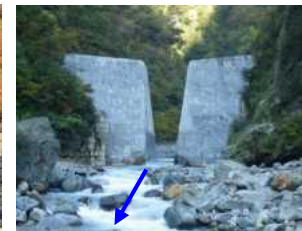
祖母谷第2号下流砂防堰堤
