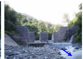
小黒部谷第1号砂防堰堤
