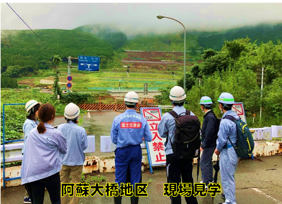
大規模崩壊斜面 現場見学
