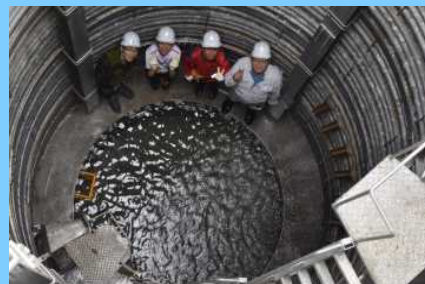
集水井内部の見学
