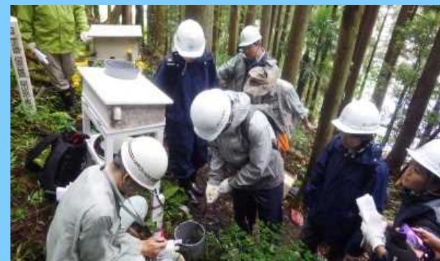
孔内傾斜計観測及び地下水調査
