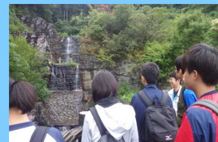
擬岩パネルで修景した堰堤
