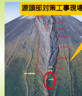
源頭部対策工事現場
