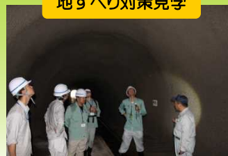
排水トンネルなどを見学
