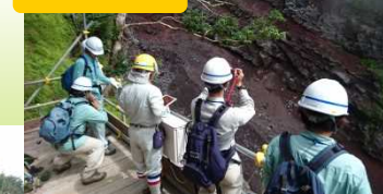
標高約2,100mの工事現場 を見学
