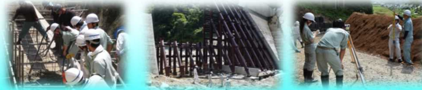
桜洞砂防堰堤 (生コン打設)
