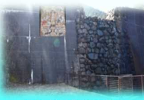
深山第1砂防堰堤
