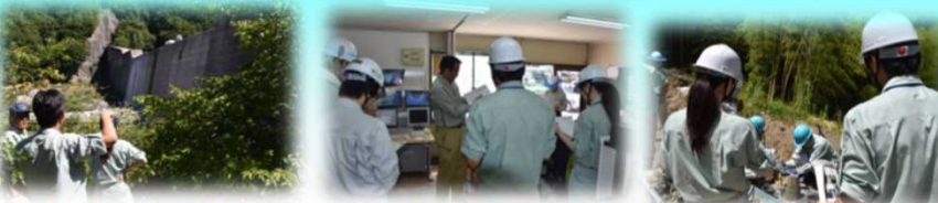
滑川第1砂防堰堤
