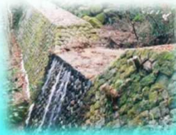
浦山第2砂防堰堤
