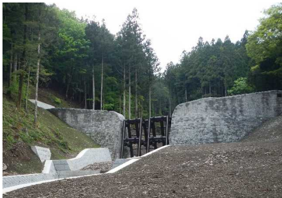
大猷院沢砂防堰堤(H31.3完成)
