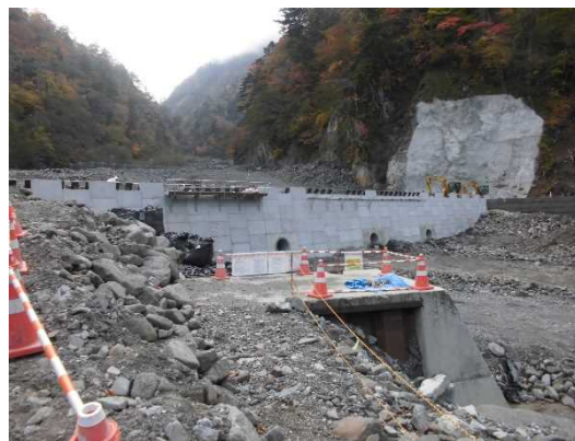
大事沢第5砂防堰堤(施工中)
