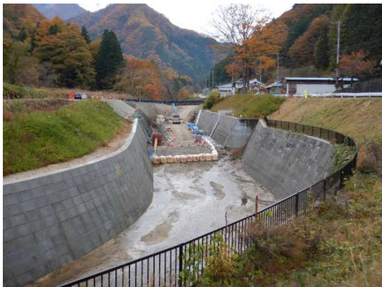
芹沢本川溪流保全工(施工中)
