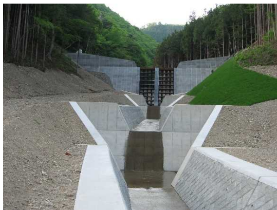
中坪下沢砂防堰堤(H29.1完成)
