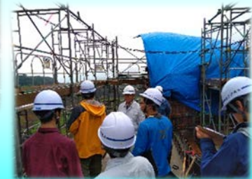
講義: 砂防工事現場体験
