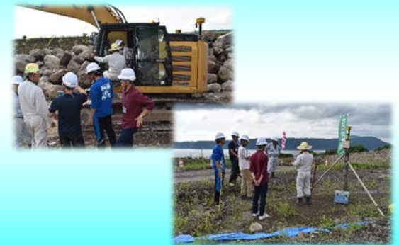
砂防工事現場体験
