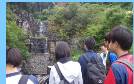
擬岩パネルで修景した堰堤
