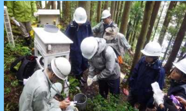
孔内傾斜計観測及び地下水調査
