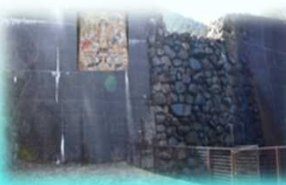
深山第1砂防堰堤
