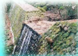
浦山第2砂防堰堤
