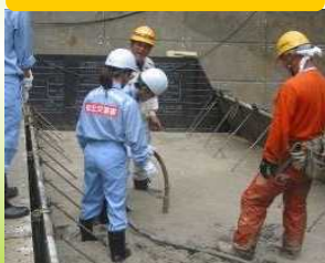
コンクリート打設体験
