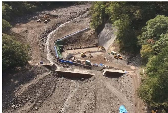
大事沢第5砂防堰堤(施工中)
