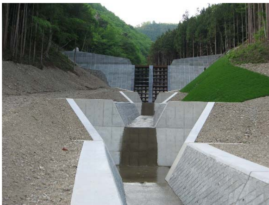
中坪下沢砂防堰堤(H29.1完成)
