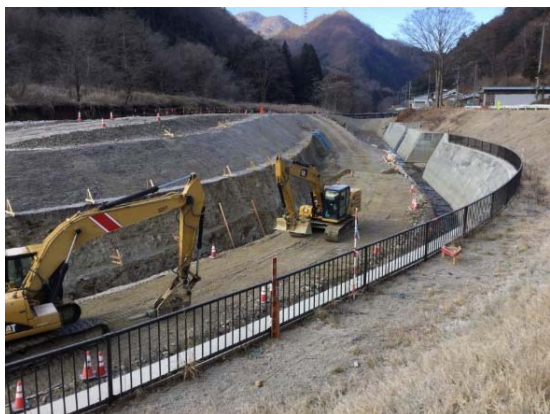
芹沢本川溪流保全工(施工中)
