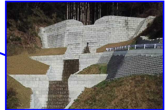
平成29年度に完成した砂防堰堤！
