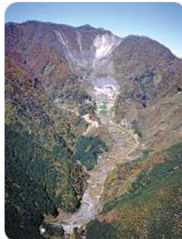
根尾白谷大崩壊地
