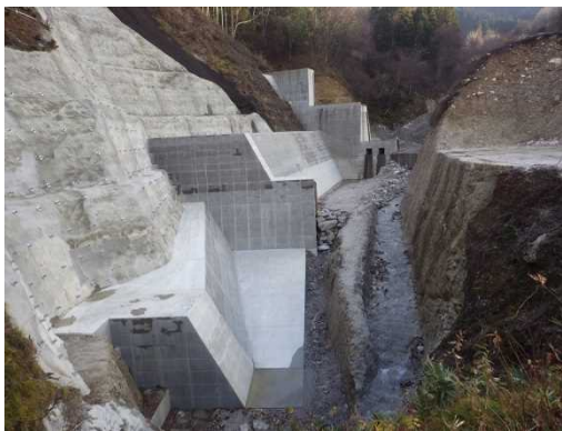
<施工状況 平成31年2月現在>
