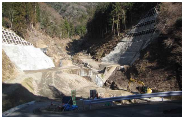
<施工状況 平成30年3月現在>
