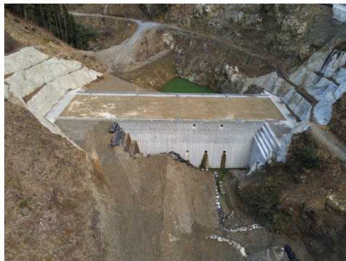
本堤の整備状況(平成31年2月)
