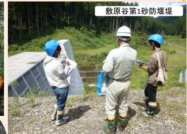
敷原谷第1砂防堰堤
