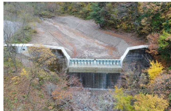
<施工状況 平成29年12月現在>
