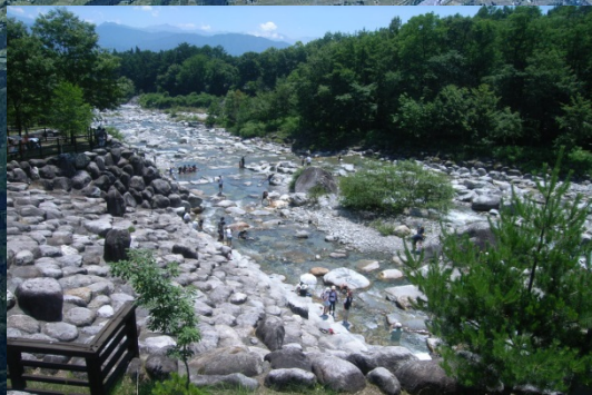
水辺空間の利用や景観を考慮した太田切床固工群
