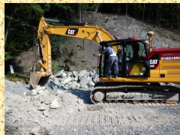
ICT重機操縦体験 (屋合沢砂防堰堤工事現場)
