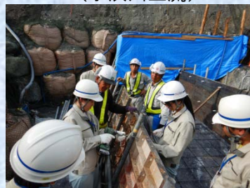
コンクリート打設体験 (塩川床固工群工事現場)
