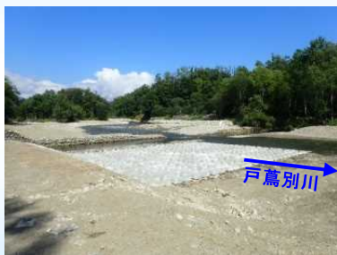
砂防施設の復旧状況
