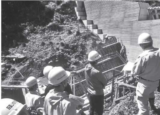
写真-1 ウルシ谷堰堤施工現場見学 (四国山地砂防事務所)
