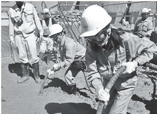
写真-2 コンクリート打設体験(立山砂防事務所)
