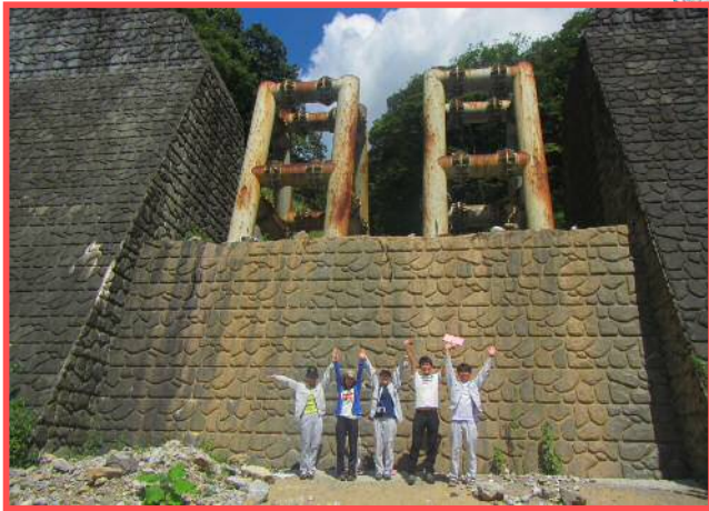
砂防堰堤の大きさに圧倒！
