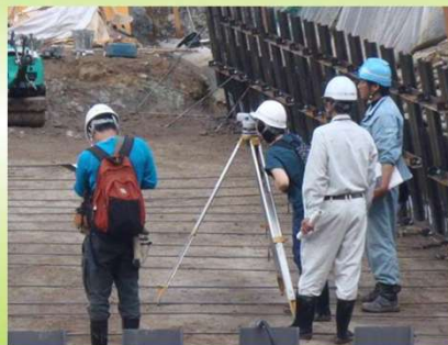
砂防工事現場管理実習
