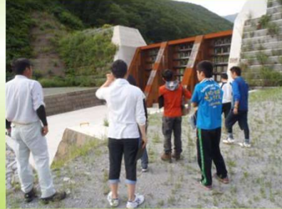
砂防工事現場見学
