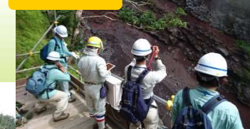
標高約2,100mの工事現場 を見学
