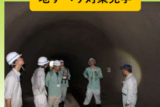
排水トンネルなどを見学
