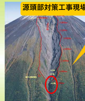
源頭部対策工事現場
