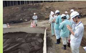
砂防の工事現場を見学
