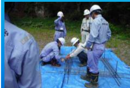
工事現場体験（鉄筋鉄枠体験）
