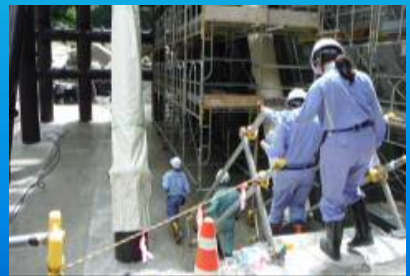
工事現場見学（大武川第五砂防堰堤）
