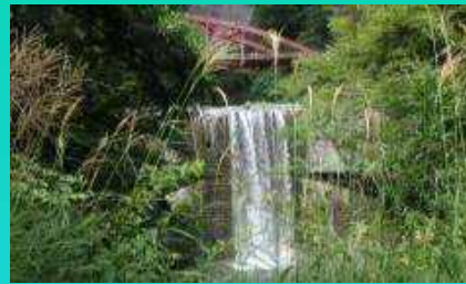
現地調査（芦安堰堤）
