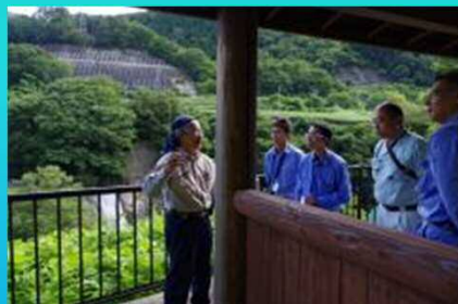
日川流域の砂防事業(勝沼堰堤)
