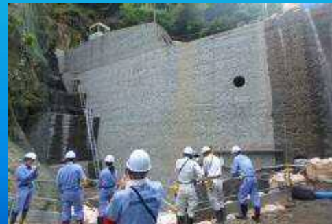
工事現場見学（夜子沢砂防堰堤）
