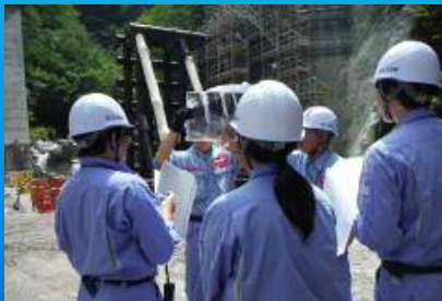
工事現場見学（大武川第五砂防堰堤）
