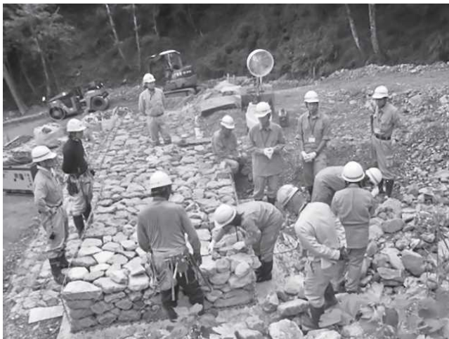
写真-2 ふとん籠工施工体験（渡良瀬川河川事務所）
