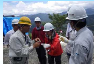
地すべり対策工見学
