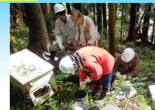
孔内傾斜計観測及び地下水調査
