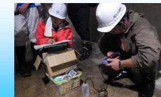
排水トンネル内部での調査
