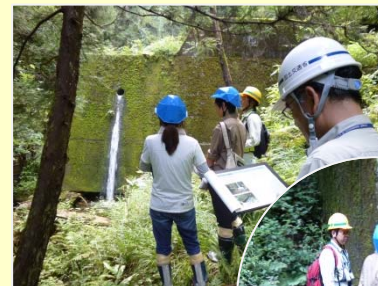
堰堤設計現場（宮の谷）
