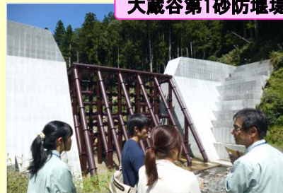
大蔵谷第1砂防堰堤
