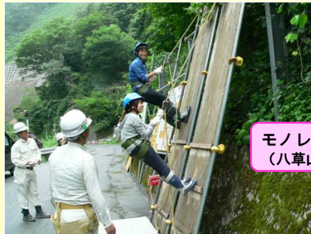
安全帯ぶらさがり体験 (八草山腹工事現場)
