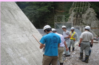
▲黒川第4砂防堰堤工事
