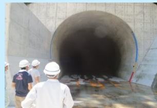
▲土砂バイパストネル
