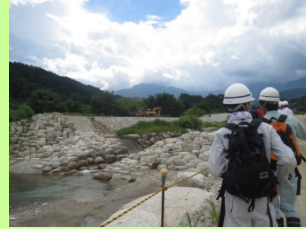
▲与田切床固工群工事
