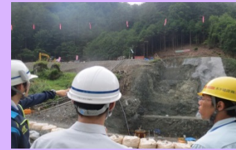
▲塩川第2砂防堰堤工事
