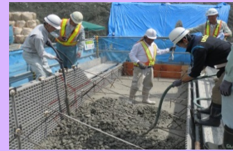
▲塩川床固工群工事現場にて作業体験
